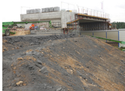
Wiadukt drogowy nad torami relacji Katowice – Kraków w Młoszowej
