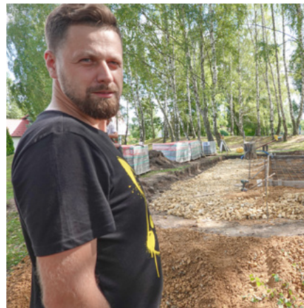
Mateusz Król, przewodniczący Rady Osiedla Siersza, dogląda prac przy ul. Ogrodowej, gdzie wkrótce stanie tężnia solankowa
