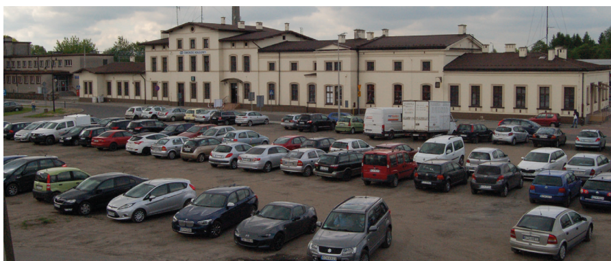
Gmina wiele lat temu zadbała o to, by kierowcy mieli gdzie zaparkować przy dworcu kolejowym. Za kilka miesięcy, w miejscu utwardzonej działki, będzie parking z kostki brukowej
