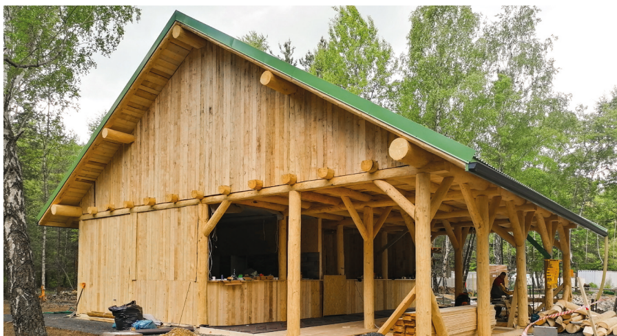
Budynek restauracji La Playa nad Balatonem powstaje błyskawicznie
