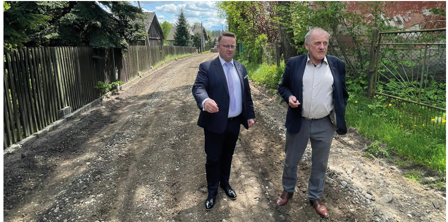
Burmistrz Jarosław Okoczuk wraz z Waldemarem Wszótkiem, sołtysiem Dulowej, doglądają, jak postępują prace związane z przebudową ul. św. Floriana
