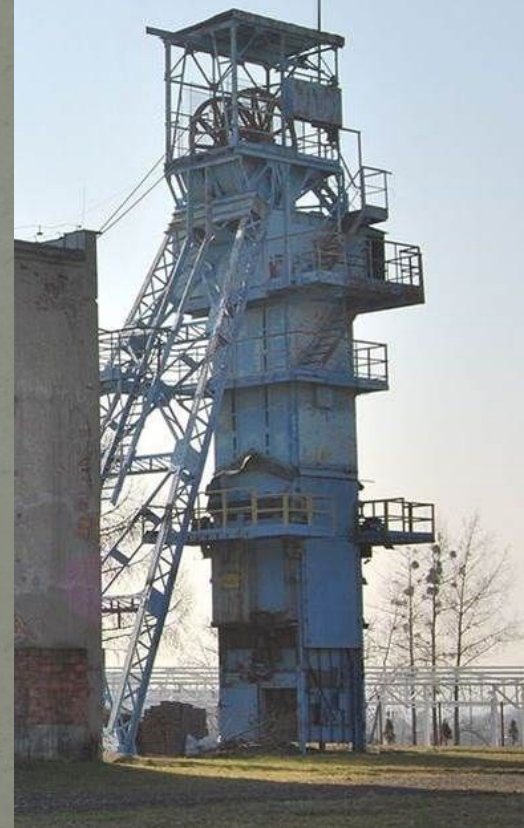
Niszcząca wieża wyciągowa Szybu „Zbyszek” w Trzebini /2015 r./
