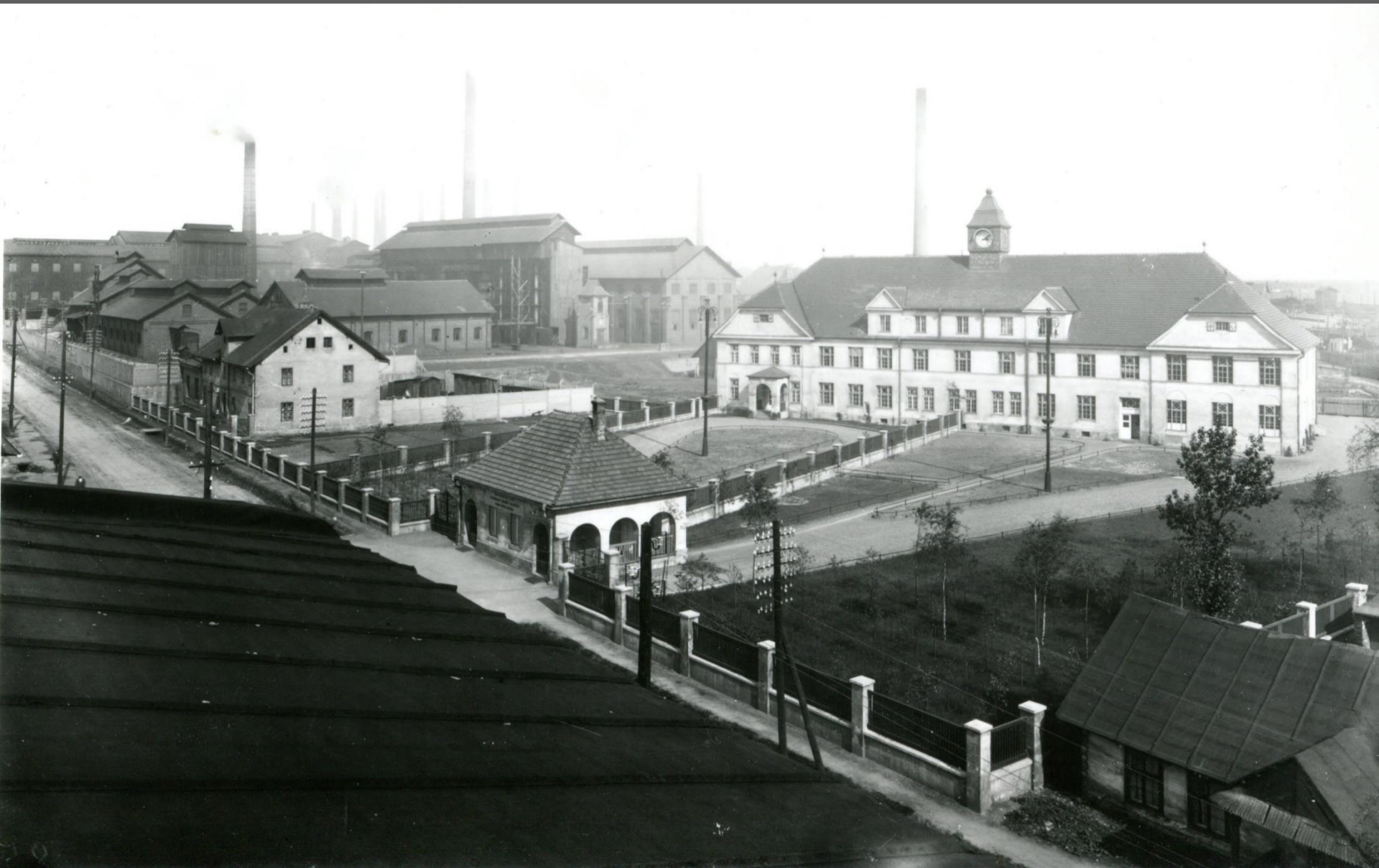
Budynki dawnej huty cynku i ołowiu w Trzebini, rok 1931 (fot. ze strony Narodowego Archiwum Cyfrowego)
